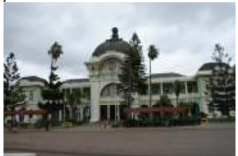
„Eiffel“-Bahnhof von Maputo in Mosambique
